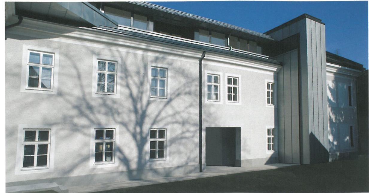
Ziel war eine behutsame Revitalisierung des Gebäudes. Das Erfassen der Gebäudestruktur bildete die Basis der Adaptierung. Das Dach wurde in seiner Grundform belassen. Der architektonische Eingriff findet straßenseitig über eine lang gezogene Schleppgaube statt um die dahinterliegende Erschließungszone zu belichten.
