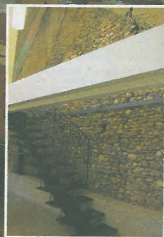
Flusssteinmauer mit Kachelbruchereinschluss
