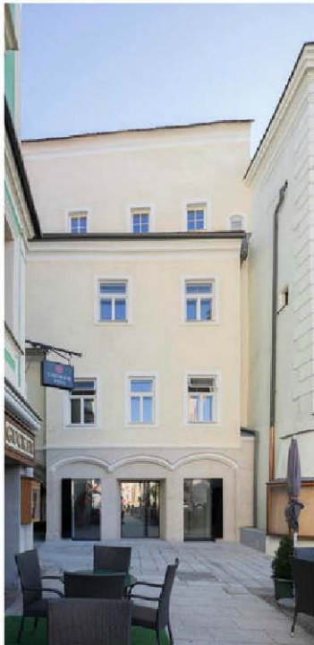
Das frisch sanierte Stadthaus Gruber vom Hauptplatz aus gesehen.
